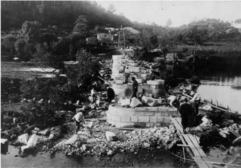
Figura 2. O alcalde e varios concellais visitan as obras de Sarandón, 1926
