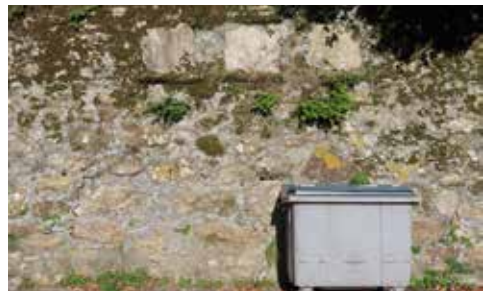
Foto 16. Muro en Corcubión
