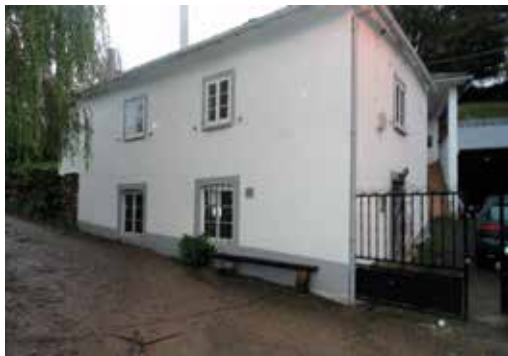
A casa de Chelo, renovada
