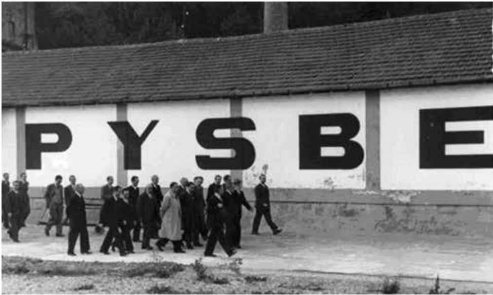
A empresa PYSBE adquiriu en 1928 os edificios dos antigos Astilleros de Pasajes de San Juan, construíndo un peirao de 350 metros (Foto Arquivo Untzi Museoa)
