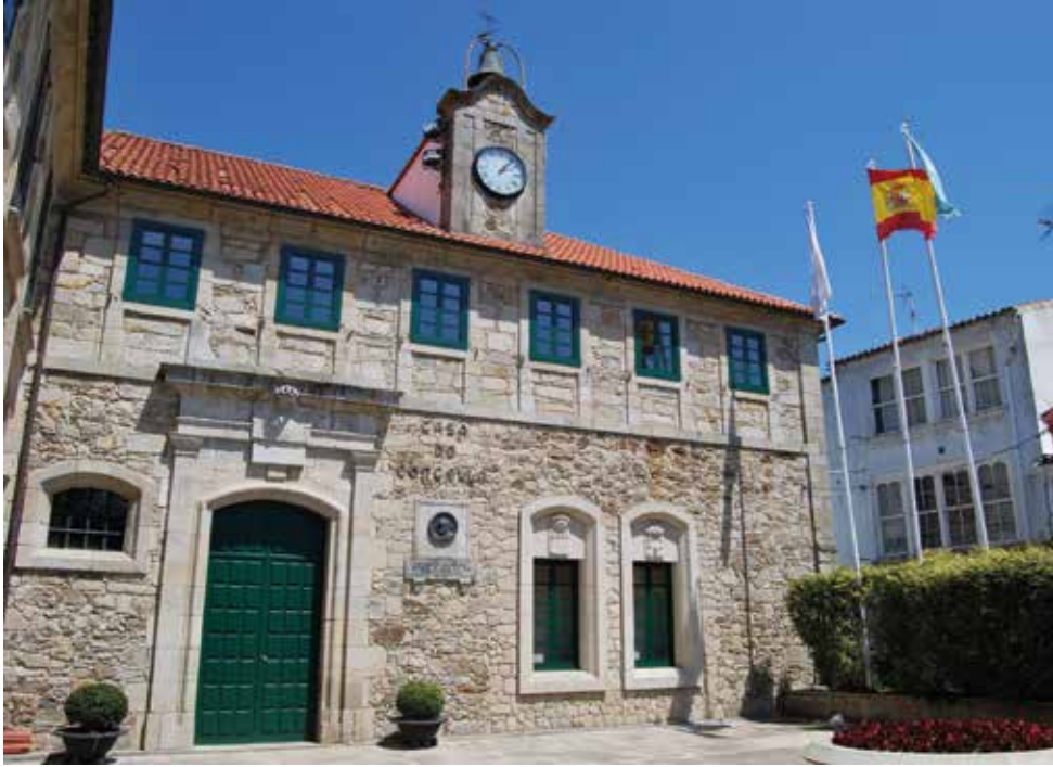
Figura 3. Fachada da Casa Consistorial de Ortigueira na que se ve o reloxo que Iglesias instalou en 1862, xunto coa campá. Foto: Jorge Castro Ruso/Wikipedia, 2009
