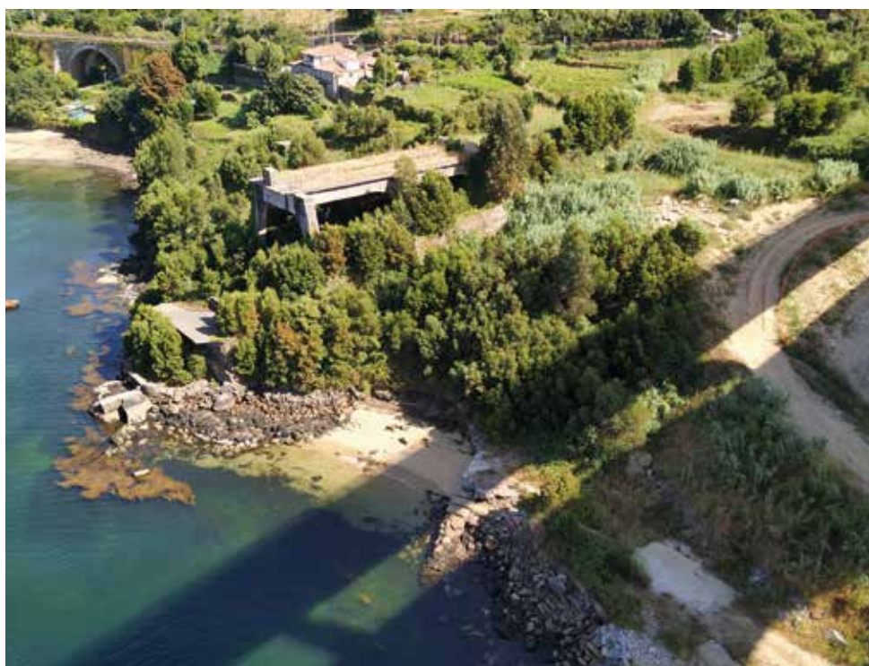
Vista actual dos restos que aínda persisten co cargadoiro dende a Ponte de Rande
