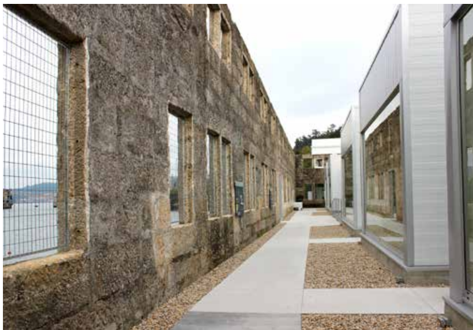
Imaxe actual da Fábrica rehabilitada como Centro de Interpretación.
