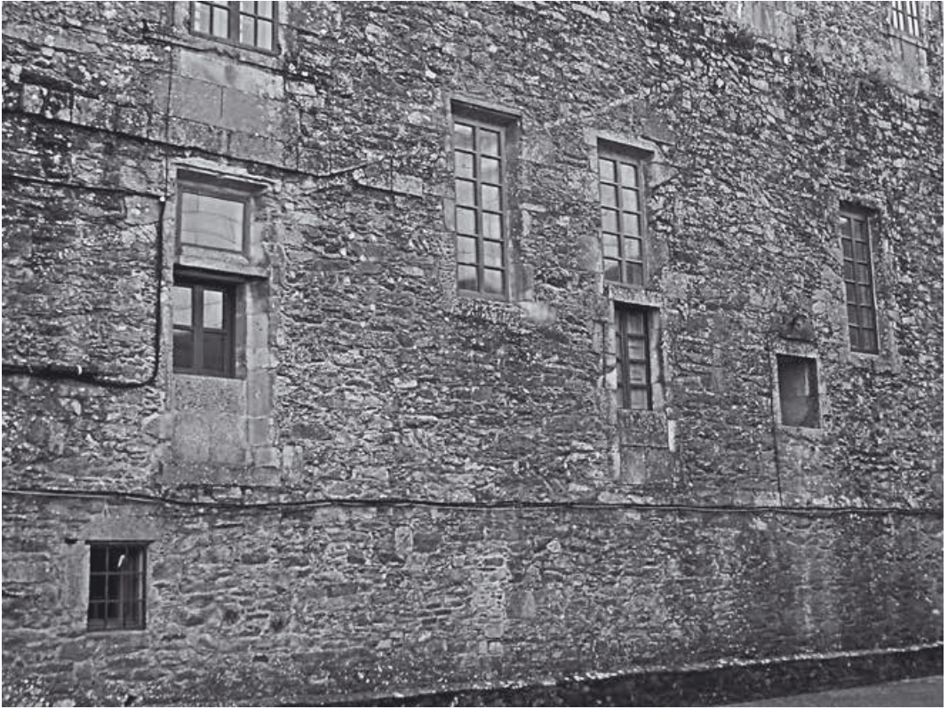
(Fig. 9) Fotografía actual da ala oeste do convento onde estivo situada a cociña exterior do hospicio. Aprécianse dúas marcas de rozás de tellado: a máis alta e coa parte do tellado da esquerda máis longo – tejadillo sobre el corredor – sinala onde estaba situada a cociña acondicionada de 1841; a roza máis baixa e coas dúas partes do tellado do mesmo tamaño sinala onde estaba situada a nova cociña de 1883. (Fotografía da autora)
