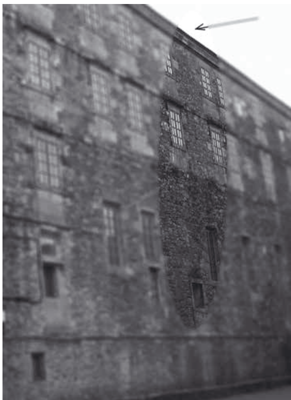
(Fig. 11) Fotografía actual da ala oeste do convento. Na zona nítida pódense distinguir as marcas do fume, tanto a da cociña da lareira sobre a fiestra de forma cadrada, como a da cheminea de ladrillo que vai todo ao longo da parede. Apréciase tamén unha pedra de diferente cor, –sinalada por unha frecha– colocada para reconstruír o lugar por onde o sobrepasaba a cheminea. (Fotografía da autora)
