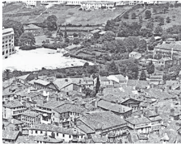
(Fig. 7) Fotografía aérea de 1968-. Apréciase o edificio de Bonaval e a cociña de 1883 pegada ao convento, coa nova cheminea que sobresa do tellado; aprécianse, tamén, as dúas dependencias da panadería-despensa e do forno. (AMPG)
