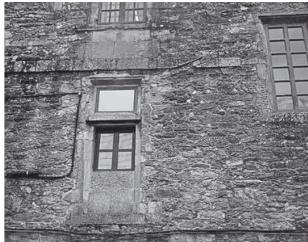
(Fig. 15) Fotografía actual dun primeiro plano da fachada da ala oeste do convento. No lado esquerdo da fotografía apréciase a xanela convertida en porta –coa roza do tejadillo que ía sobre o corredor– para comunicar a cociña acondicionada de 1841 coa dependencia interior do convento onde estaba situada a cociña do século XVII. (Fotografía da autora)
